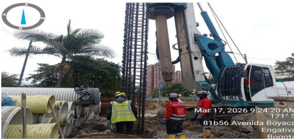
Fuente: interventoría CAL Y MAYOR COLOMBIA SAS
