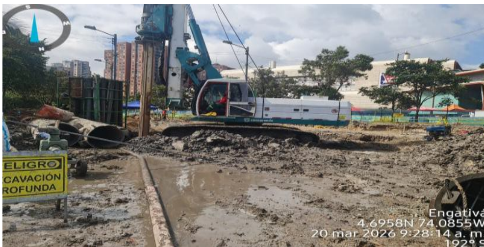
Fuente: interventoría CAL Y MAYOR COLOMBIA SAS
