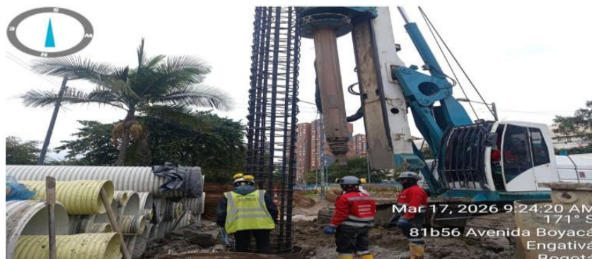
Fuente: interventoría CAL Y MAYOR COLOMBIA SAS
