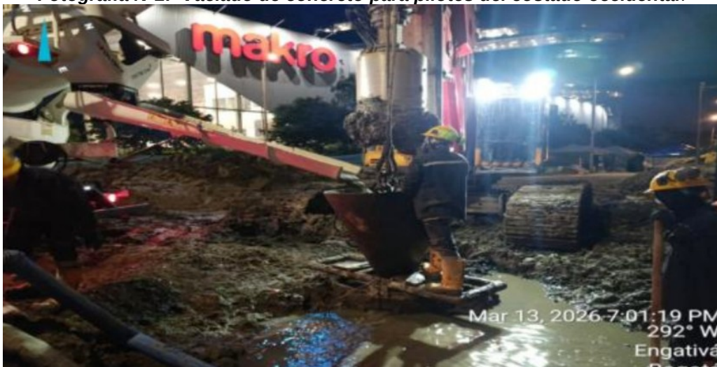
Fotografía N°2: Vaciado de concreto para pilotes del costado occidental.
