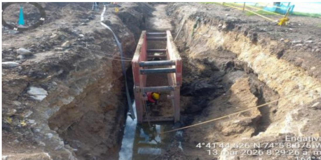
Fotografía N°3: Instalación de tubería para desvío de red sanitaria, costado oriental
