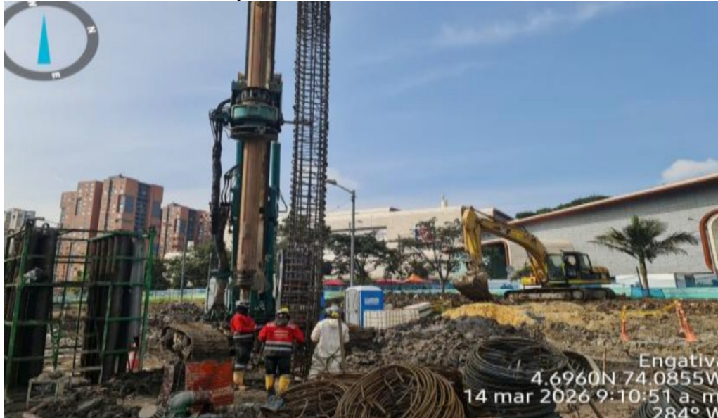
Fotografía N°1: Izaje de canastila de acero para posterior vaciado de concreto para pilotes del costado oriental.
