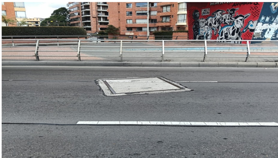
Imagen No. 3: Fotografía de la visita realizada el día 21 de febrero de 2026. Fuente: DTCI- IDU
