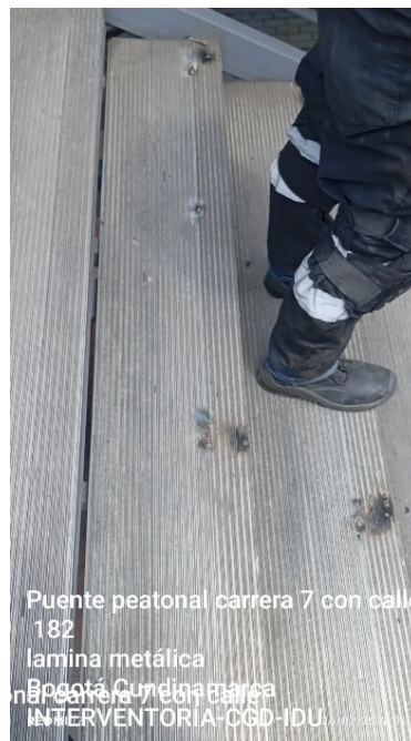
Fotografía No.2: intervención en tercer escalón
