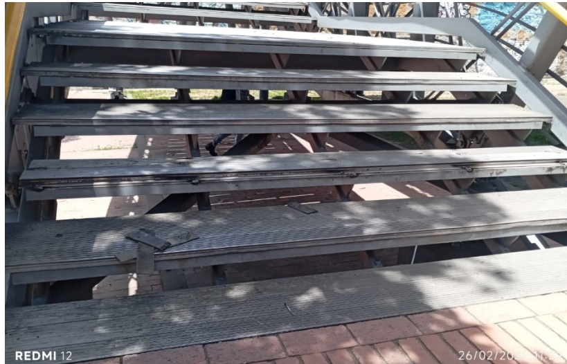
Fotografía No.1 Escalones puente peatonal
