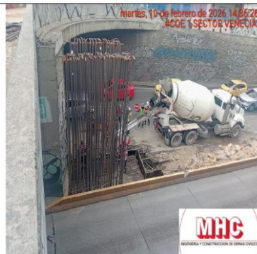
Ilustración 1 INSTALACION DE CONCRETO Y CONSTRUCCION APOYO INTERMEDIO RETORNO
