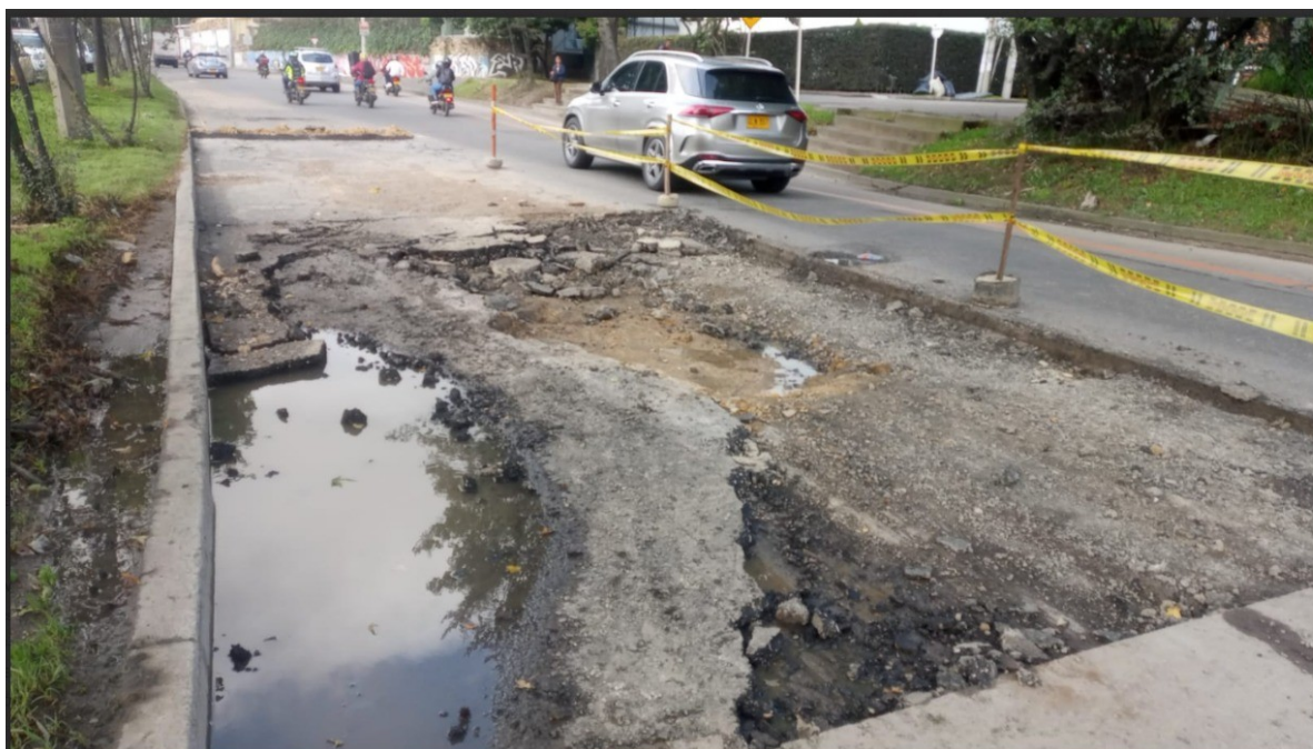
Imagen No. 1: Panorámica del segmento vial requerido evidenciado la obra adelanta por la EAAB del Cto. IDU-1660-2024. Fuente: CONSORCIO CCC – GRUCON BOGOTÁ
