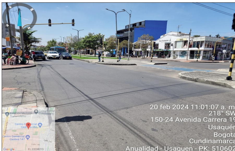
Fotografía 1. Intervención AK 19 con CL 150 CTO 1759-2021
