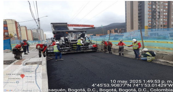
Instalación MD-20, MS-12 y MD-12 entre calle 188 -
