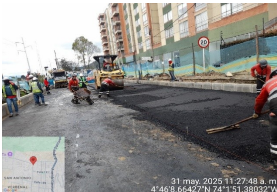
Instalación de MD-20 del K2+280 a K2+320.
