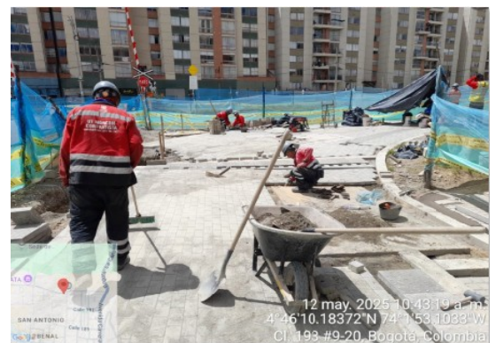
Conformación de espacio público K2+330.
