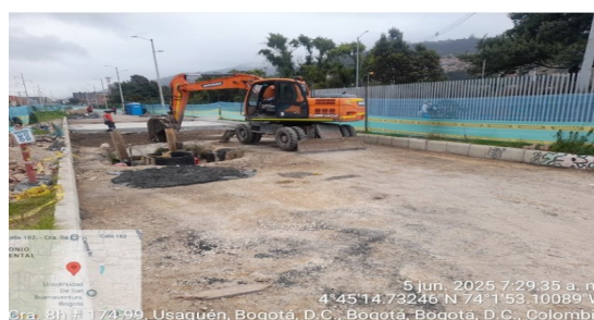
Fundida de anillos y relleno cámara K0+660
