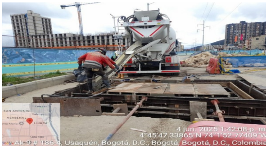
Fundida de muros cámara Manhole K1+650 189
