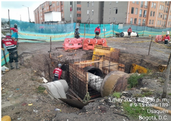
Armado de acero de muros en cámara 67.
