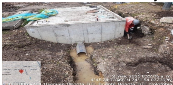
Excavación para instalación accesorios cámaras VRP
