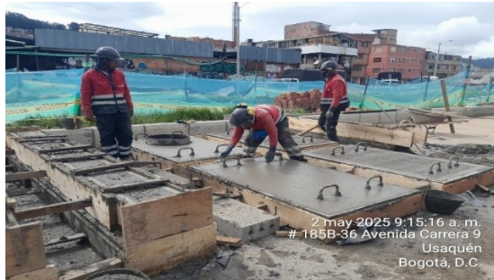
Fundida de vigas y tapas para cámara de red matriz
