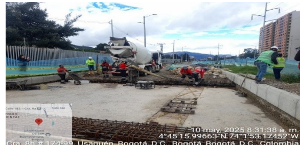
Fundida de vigas pontón del canal El redil
