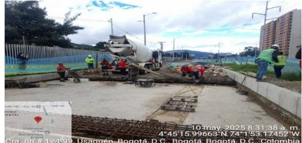
Excavación para instalación accesorios cámaras VRP Fundida de vigas pontón del canal El redil
