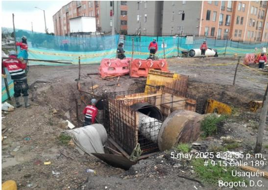
Armado de acero de muros en cámara 67.
