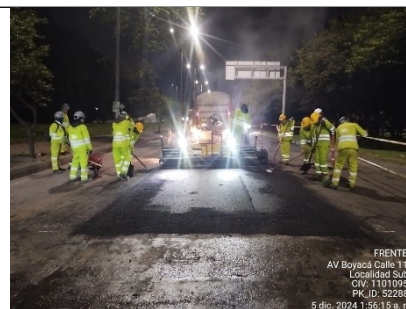
Actividades de parcheo en A.K.Boyacá, costado occidental
