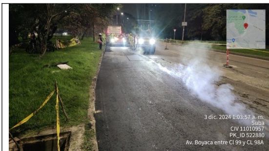
Actividades de parcheo en A.K.Boyacá, costado occidental
