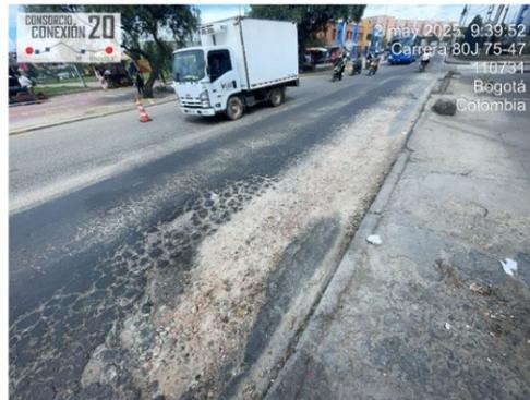
Fotografías 1. Estado deterioro de carpeta asfáltica Carrera 80J – Daños reportados por la comunidad.
