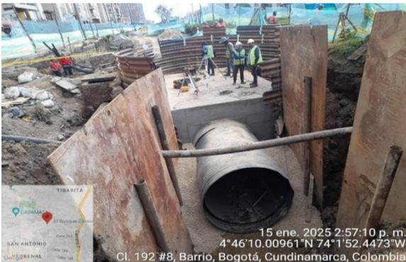
Instalación tubería de 1800mm HDPE en Tramo 2
