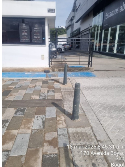
Foto – Reposición de bolardo vandalizado – Fuente Consorcio Malla Vial Bogotá
