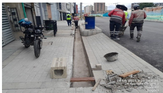
Instalación rejilla cárcamos tramo 1.
