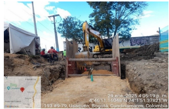
Relleno de tubería de 1800mm HDPE en Tramo 2
