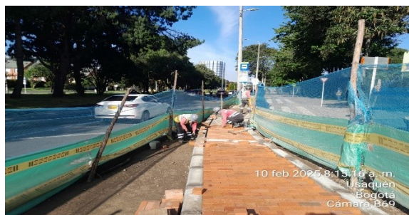
Conformación de espacio público en Sector 2, Tramo 1.
