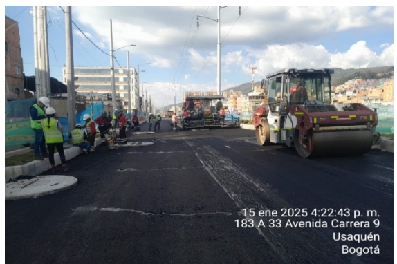
Instalación de asfalto MD-GCR en Tramo 2
