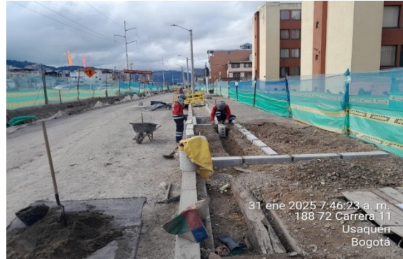
Instalación de prefabricados A-80 en Tramo 2.
