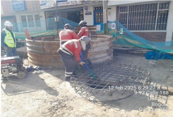
Construcción de PZ #CMP3570 K1+816 Tramo 2.
