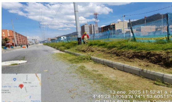
Limpieza de vegetación tramo 1.
