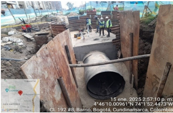
Instalación tubería de 1800mm HDPE en Tramo 2
