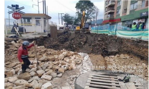
Conformación estructura de vía con rajón en Tramo
