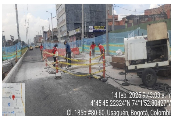
Renivelación de cámaras de Red Matiz en Tramo 2
