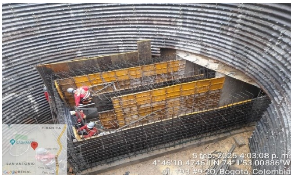
Fundida de cámara #70B en Tramo 2
