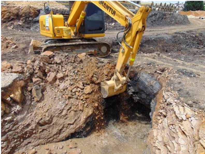
Momento en el que se hallan las estructuras Fuente: Agrupación Guinovart Obras y Servicios Hispania S.A., 2022
