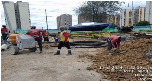
Excavación lumbrera Tramo Túnel Liner K2+165
