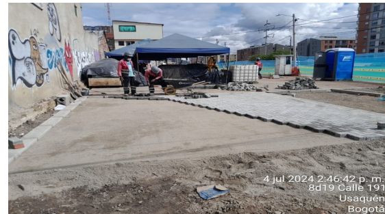
Instalación de Adoquín de concreto K2+100
