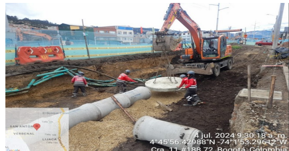
Instalación de tubería en concreto reforzado de Ø50 cm
