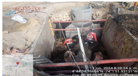
Construcción de pozo red pluvial K0+022
