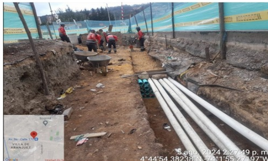
Instalación de tubería ETB y lleno
