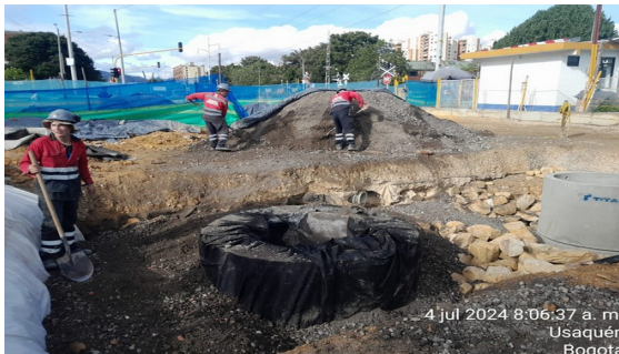
Relleno de rajón y sello calle 170 K0+030
