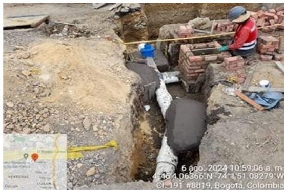
Instalación de tubería y Accesorios 8" agua potable.
