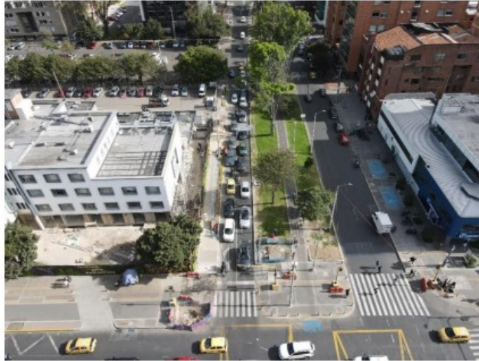
Ilustración 2 Fotografía aérea del 22 de agosto 2024. Cra 19 habilitada completamente. (...)”
