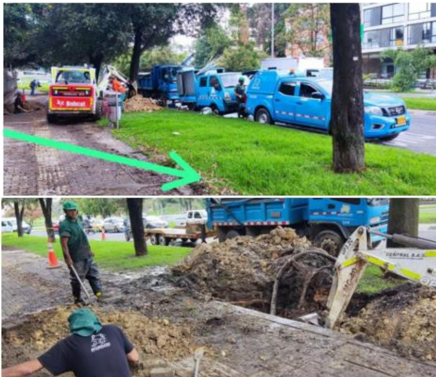
Presencia de maquinaria sobre las zonas de andenes, excavación sobre áreas de espacio público y zonas verdes
