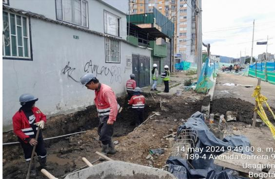
Excavación para instalación de redes acueducto de 8", 12" y Enel K1+992.
