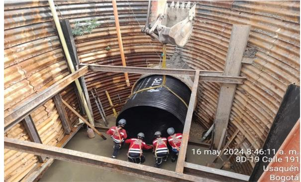
Instalación tubería de 2m Colector Buenavista K2+160
