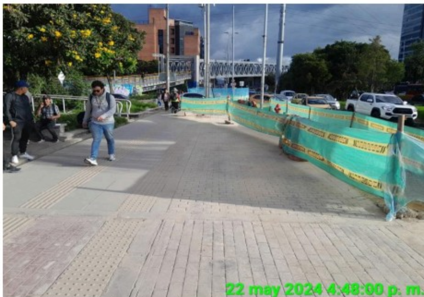
Espacio Público en ejecución entre calles 116 y 114 debidamente señalado.
