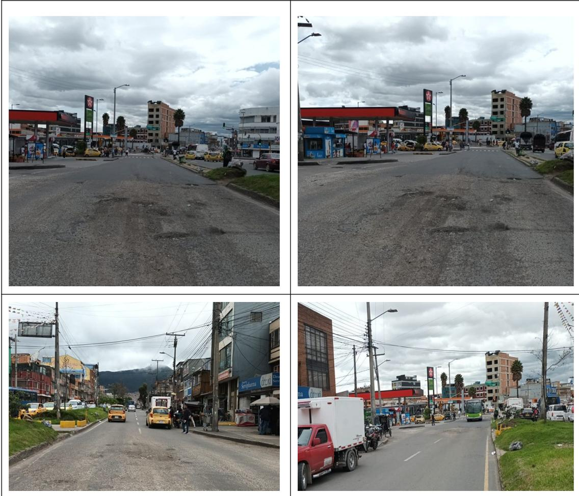
Por lo anterior, se evidencia que se presenta daño en la carpeta de rodadura del pavimento, con desplazamiento de material granular.
