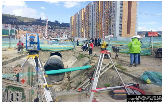
Excavación Lumbrera para Red Pluvial.(Tunel Linner) Instalación Tubería 1,6m canal Canaima K1+950
