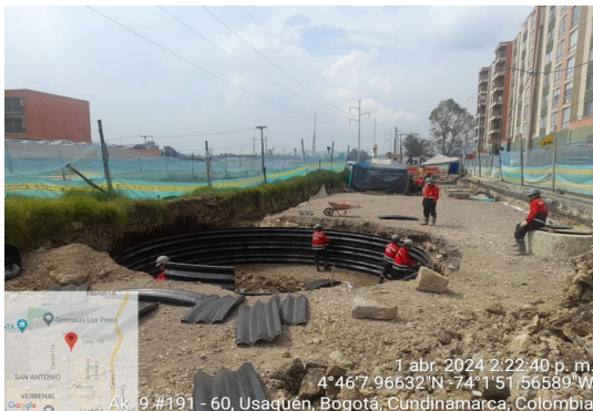
Excavación Lumbrera para Red Pluvial.(Tunel Linner) Instalación Tubería 1,6m canal Canaima K1+950
