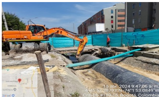
Instalación y rellenos tubería de 1,6m K1+950.
