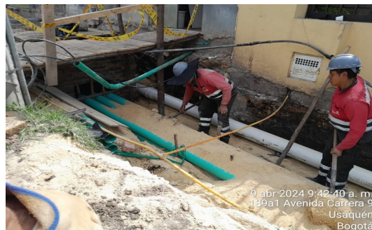
Instalación y rellenos redes de Enel y Acueducto de 8" y 12" K2+020
