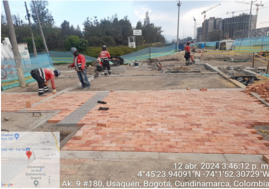
Instalación de adoquín de arcilla calle 180.
