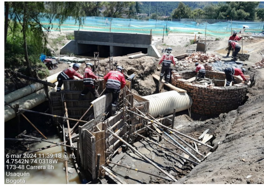
Encofrado para fundida cabezal de pozo Provisional.
