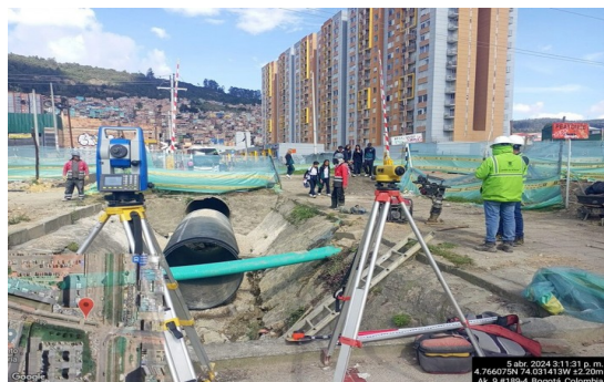
Instalación Tubería 1,6m canal Canaima
