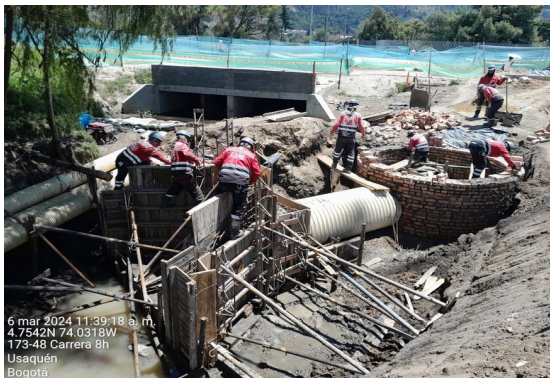
Encofrado para fundida cabezal de pozo Provisional.
