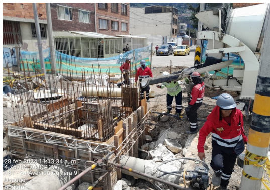
Fundida cámara red pluvial.
