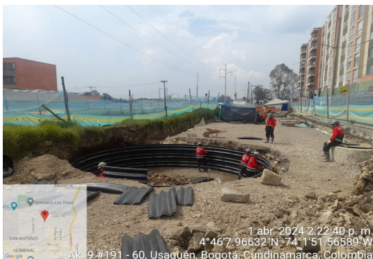
Exvación Lumbreira para Linner K2+280 K1+950 Red Pluvial.
