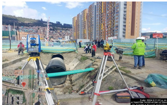
Instalación Tubería 1,6m canal Canaima K1+950
