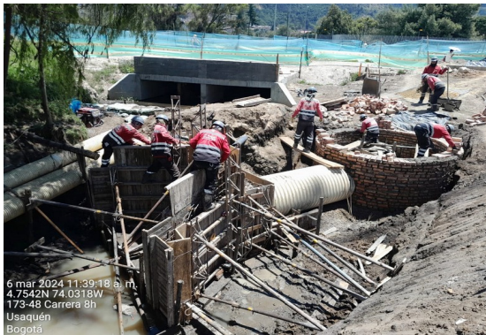
Encofrado para fundida cabezal de pozo Provisional.
