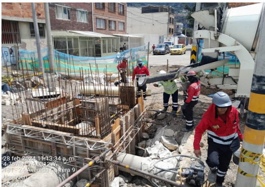
Fundida cámara red pluvial.
