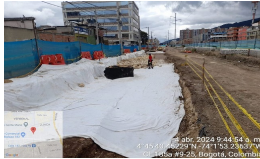
Relleno rajón y SBG-C para Estructura de vía
