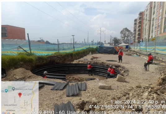
Exvación Lumbera para Linner K2+280 Red Pluvial.
