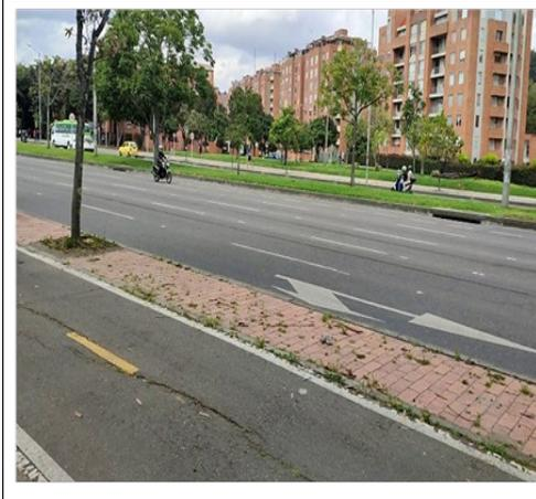
presencia de fisuras, levantamiento de la capa asfáltica por raíces en zona puntual, deterioro de la capa asfáltica contra el confinamiento en toda su longitud, vados con desgaste superficial
