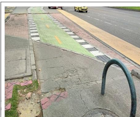
fisuras incipientes,desgaste en toda la longitud de ciclorruta contra prefabricado,fisuras transversales,vados con desgaste superficial,desintegracion de prefabricado
