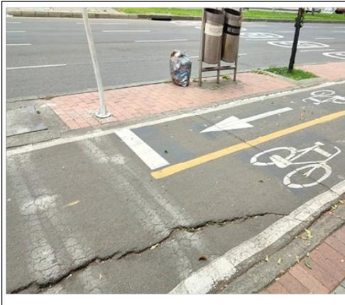
Grieta debido al hundimiento de la estructura, presencia de material vegetal a lo largo del carril
