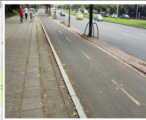
presencia de fisuras, levantamiento de la capa
