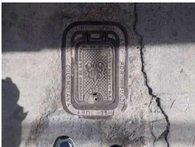
Medidor de agua
