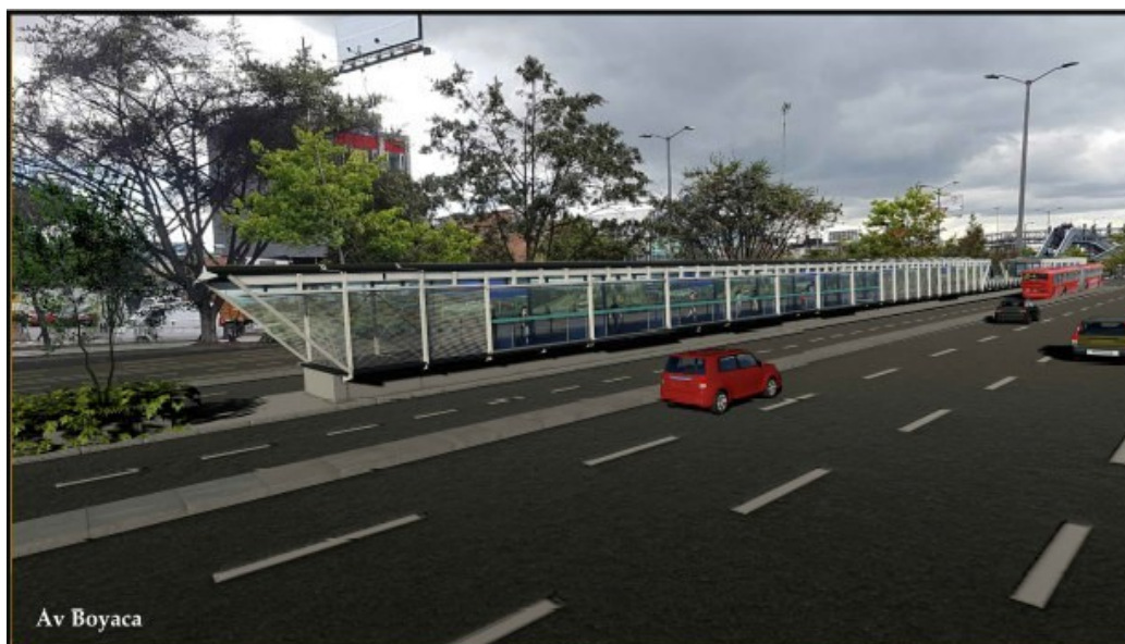
Figura 2 - Render Estación Av. Boyacá Troncal Calle 80 - (fuente - informe interventoría)
