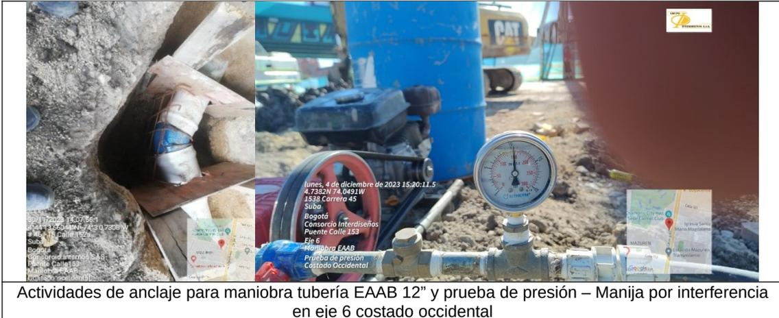
Actividades de anclaje para maniobra tubería EAAB 12" y prueba de presión – Manija por interferencia en eje 6 costado occidental
