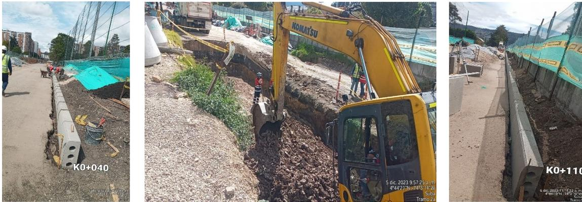
**Tramo 2 (Canal Córdoba a Kr 58 Proyección Av. Villas):** Se realizó la instalación de las redes secas, redes húmedas, se conformó la estructura de la vía y se instaló la primera capa de asfalto en grano caucho. Actualmente se avanza en la instalación de prefabricados de contención, la conformación de la estructura del espacio público y separador, así como la elaboración de los sistemas urbanos de drenaje.
