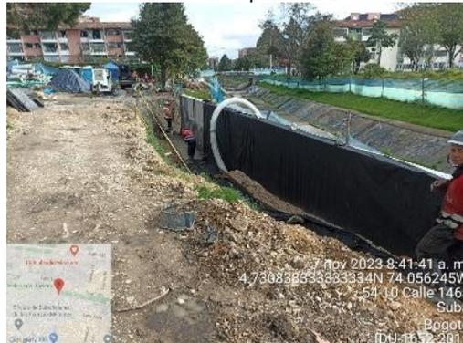
SECTOR 4 occidental 146a-147= instalación de filtro en muro 10 módulo 3
