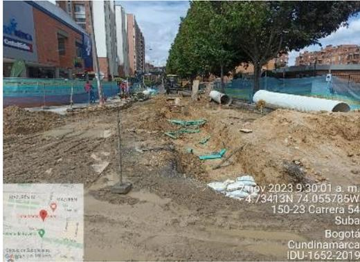
SECTOR 5 occidental 151-152= Instalación de relleno en tubería pluvial entre pozos PZ-96 y PL-81A
