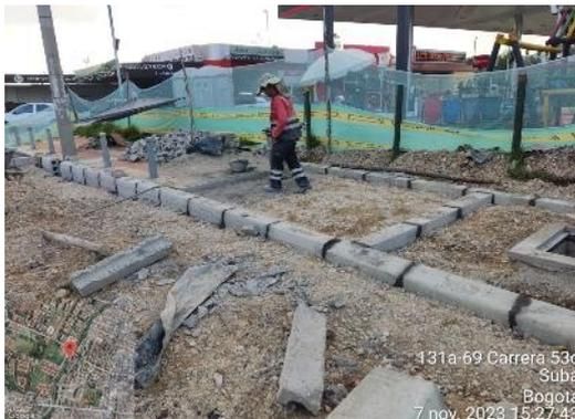
SECTOR 1 Occidental entre calle 131b y calle 134=instalación de prefabricado A-80 A85 y A10 en rampa frente a estación texaco
