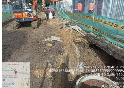
SECTOR 4 oriental 145c-146= Instalación de relleno B-200 en tubería sanitaria entre pozo PZ-174s a PZ-174A
