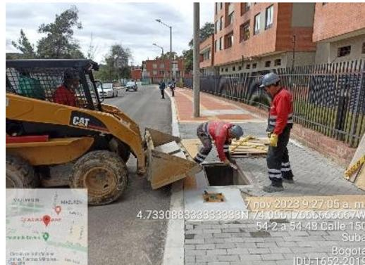
SECTOR 5 occidental 149-150= Instalación de tapas de concreto en cajas de inspección red Codensa
