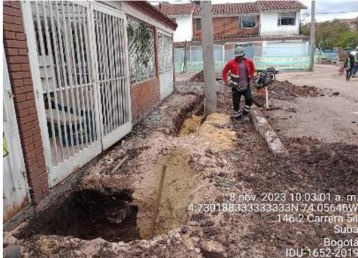
SECTOR 4 occidental 145c-146= Excavación para construcción de cajas domiciliarias
