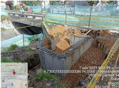
SECTOR 4 oriental 146-146a= instalación de relleno B-200 en estribo puente 146a costado sur oriente
