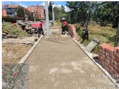
SECTOR 1 Occidental entre calle 131b y calle 134 = nivelación de arena de base e instalación de adoquín
