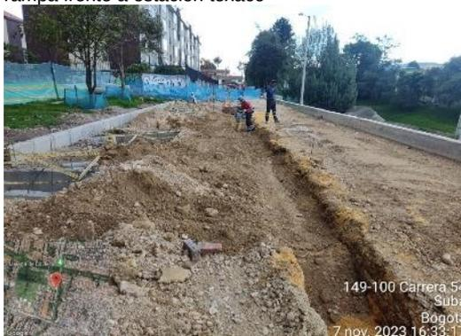
SECTOR 3 Occidental entre calle 143A y calle 145C = compactación de material SBGC en zanja de tubería eléctrica afectada 2Diam3" 6 Diam 4"
