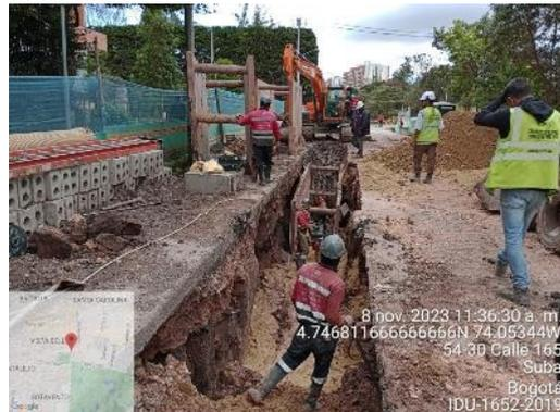
SECTOR 8 oriental calle 163-167= Excavación de tubería pluvial, instalación de arena de Peña y tubería 8"
