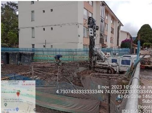
SECTOR 4 oriental 146a-147= Instalación de concreto en micropilotes de estribo puente 146 costado nororiente
