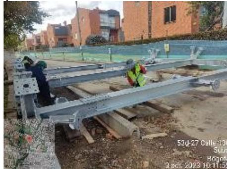
SECTOR 1 Occidental entre calle 129b y calle 130 = construcción de estructura metálica del puente calle 130
