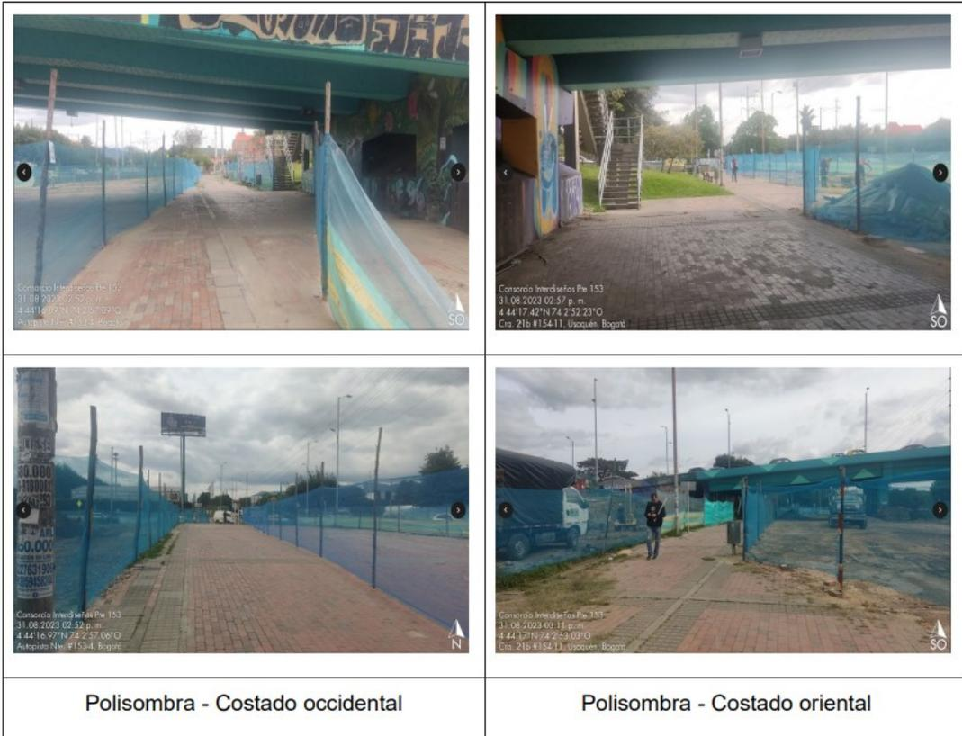
5. En el costado oriental se instala refuerzo de polisombra en la zona bajo el puente de la 153, ya que se evidenció que en la ejecución de las actividades relacionadas con el pilotaje, estaba saliendo material (Lodo + Polímero), al sendero peatonal.
