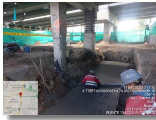
Entre el sábado 22 de julio, continuando hoy 24 de julio de 2023, se han adelantado actividades relacionadas con la demolición de la placa para la perforación de micropilotes, en el eje 5, costado occidental del puente, como se observa a continuación:
