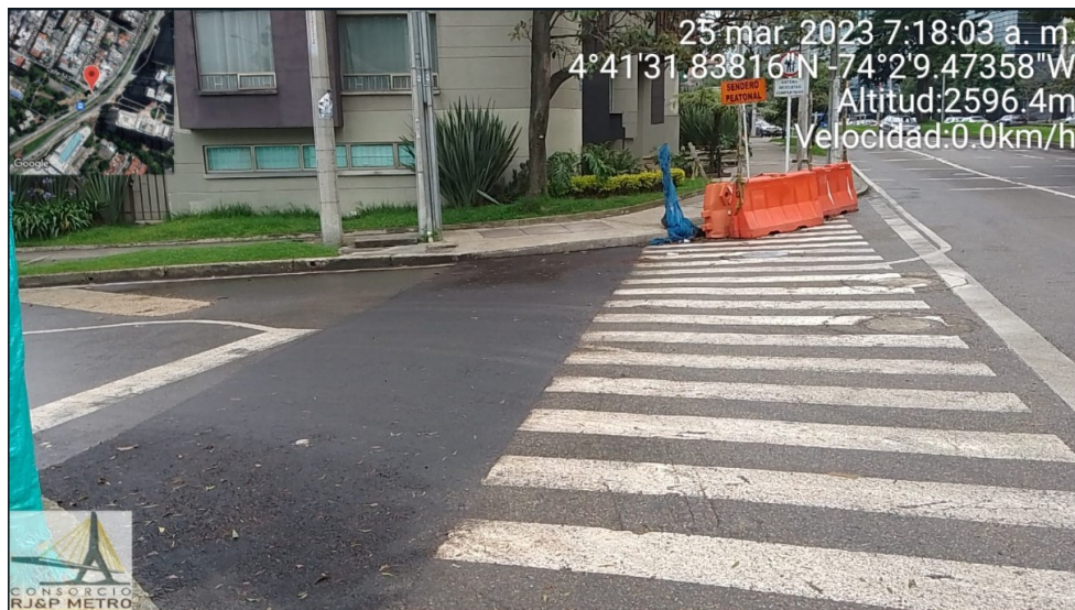
Foto 2. Pavimentación Cruce de vía Cra. 9 calle 112 [25 marzo de 2023]
