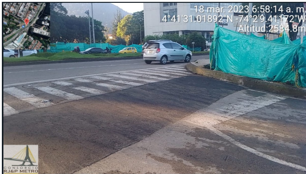
Foto 1. Pavimentación de cruce de vía [18 de marzo de 2023]
