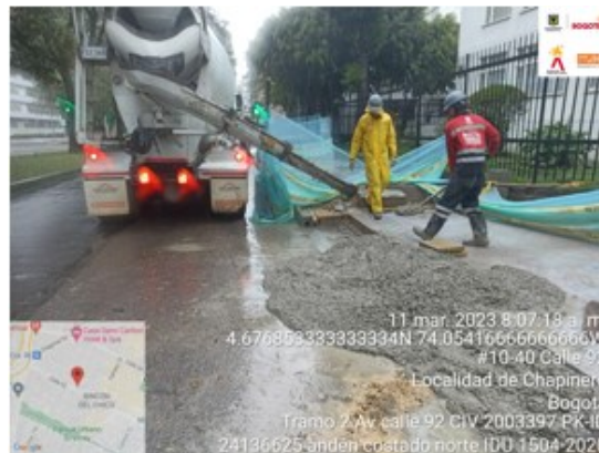
Imagen No.1 Vaciado de concreto para rampa de acceso calle 92 con carrera 18 costado norte.
