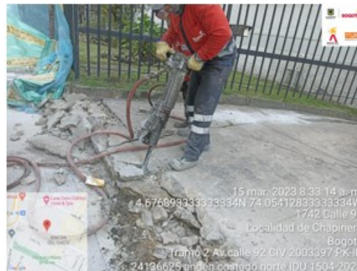
Imagen No.2 Demolición de placa existente (Predio privado), acceso calle 92 con carrera 18 costado norte.
