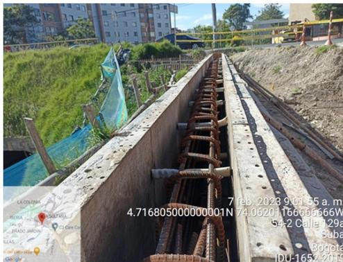
Armado de Encofrado muro 1 sector 1 occidental
