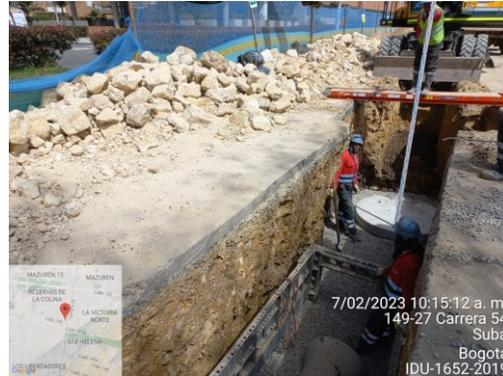
Instalación de placa base y nivelación de la misma en el sector 5 occidental
