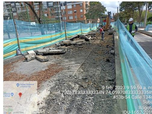
Fresado para instalación de tubería pluvial en sector 2 occidental
