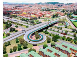
AMPLIACIÓN PUENTE VEHICULAR CALLE 153
