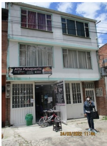
Fachada del predio
