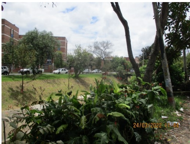
Vista del Canal Córdoba
