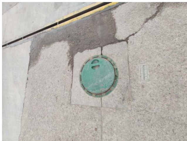
22-ZONA DE TANQUES
