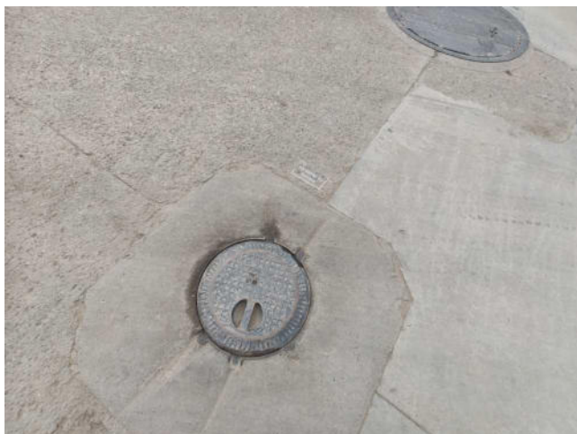
21-ZONA DE TANQUES
