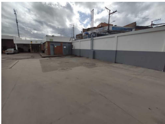
05-ZONA DURA CONCRETO
