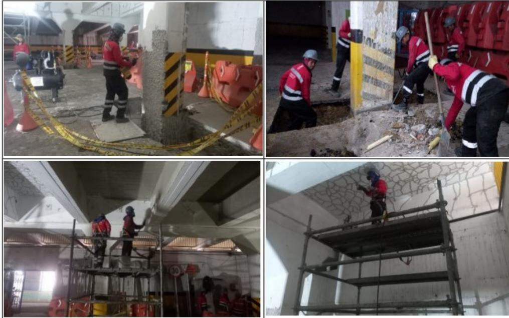
*A partir del 19 de diciembre de 2022 en horario nocturno el Consorcio Reforzamiento PTCC 2022 ejecutara actividades de obra en horario nocturno como lavado, sello, inyección de fisuras y aplicación de la barrera de CO2 (Pintura) en las zonas bajas sobre la calle 13 en carriles mixtos y exclusivos de Transmilenio.*
