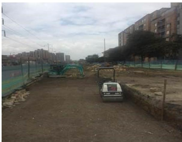
*Se han adelantado demoliciones de la carpeta de pavimento existente para iniciar con las excavaciones para redes hidrosanitarias (acueducto y alcantarillado) y redes secas (MOVISTAR, ETB, VANTI, ENEL), y se adelanta la conformación de rellenos para la estructura de pavimento de la calzada oriental de la nueva troncal Avenida 68.”*
