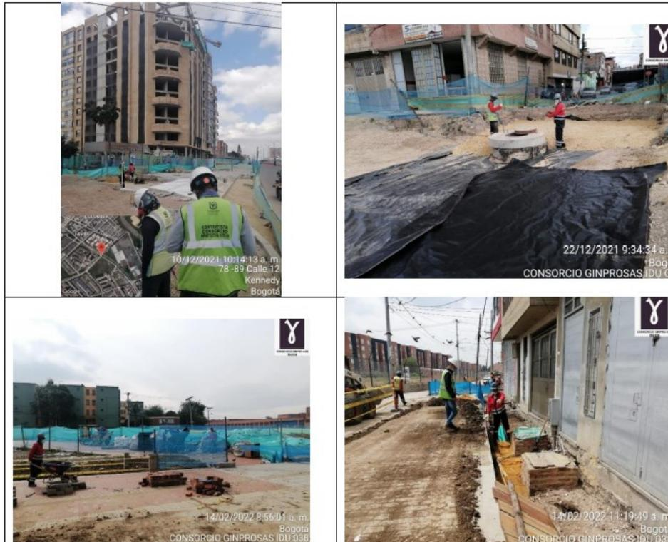
Tramo 5A: se han venido adelantando trabajos de instalación de alcantarillado pluvial al costado norte y se ha iniciado la conformación de la calzada, así mismo frente al acceso de la antigua planta de Bavaria, se ha instalado el patio de fabricación de las vigas de los puentes, de las cuales se han construido 34 de un total de 64.
