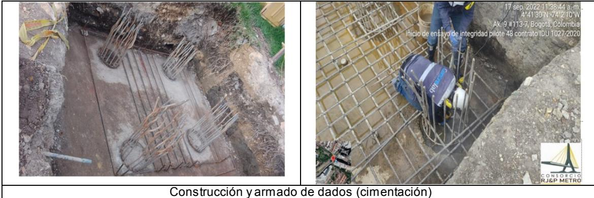
Construcción y armado de dados (cimentación)
