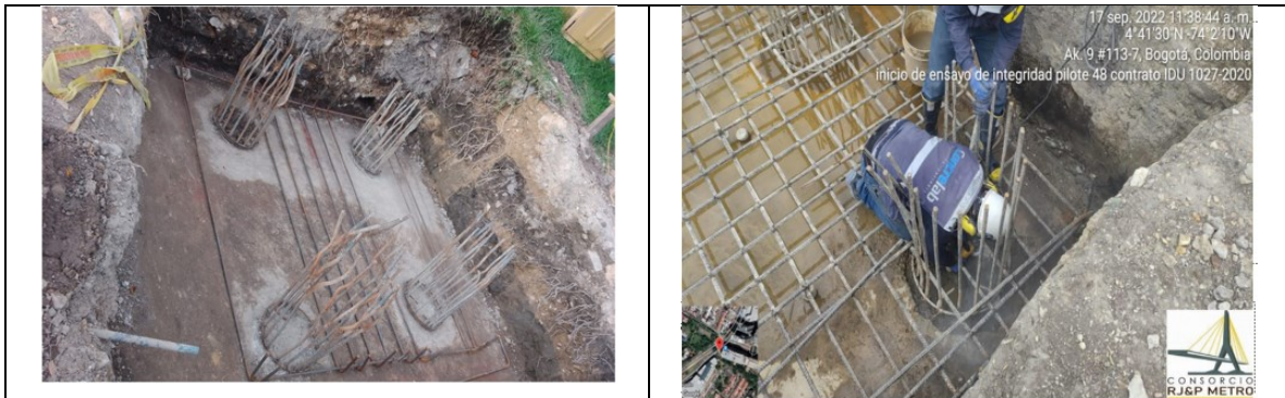
Construcción y armado de dados (cimentación)
