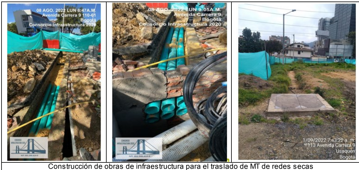
Construcción de obras de infraestructura para el traslado de MT de redes secas
