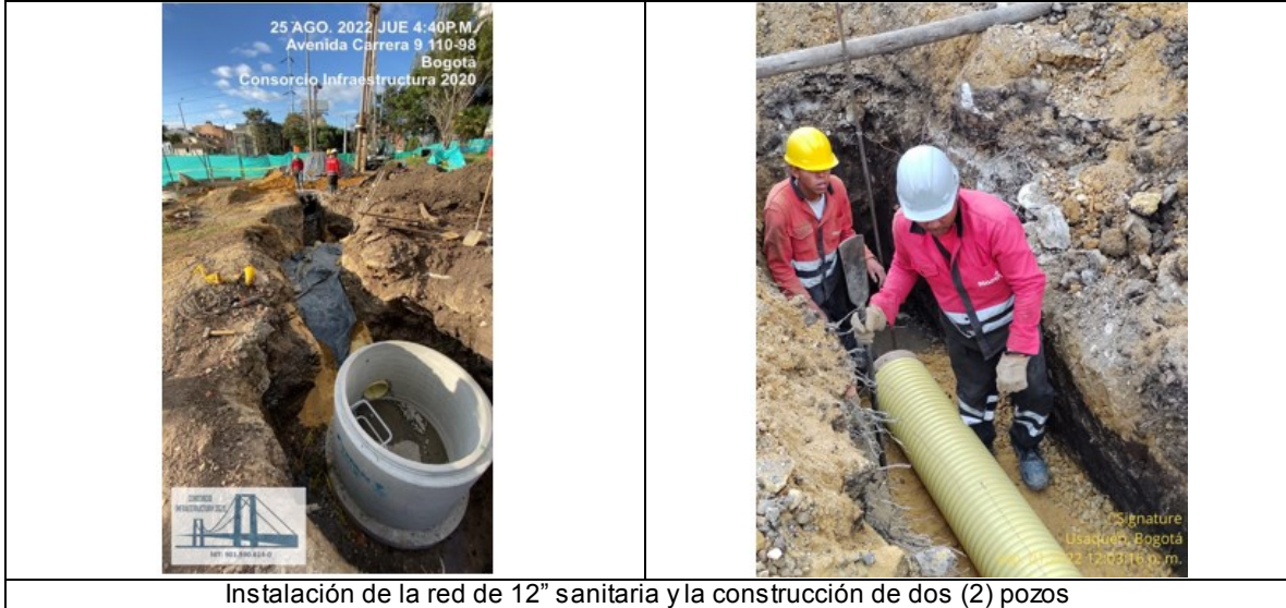
Instalación de la red de 12" sanitaria y la construcción de dos (2) pozos
