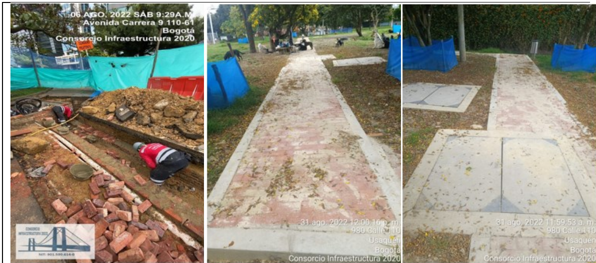
Terminación de redes secas y construcción de urbanismo costado occidental
