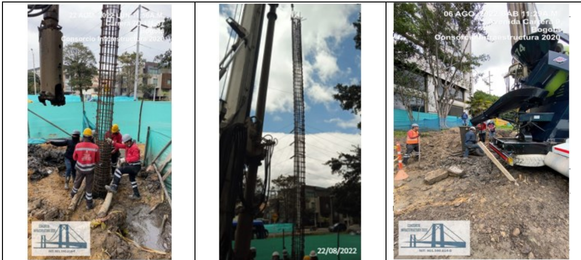
Izaje e instalación de canastas de acero para pilotes de diámetro 60cm y 80cm
