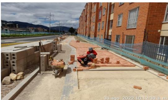
Instalación de adoquín en arcilla. CALLE 170 - CALLE 183 y Excavación manual para instalación de elemento prefabricado tipo A-81.
