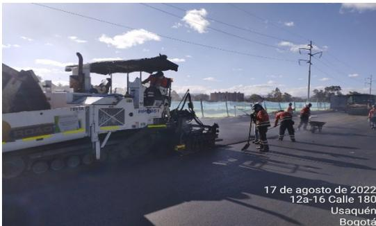
Instalación de mezcla asfáltica modificada con grano de caucho tramo Av. 9 Calle 172 -calle 175 Costado oriental.
