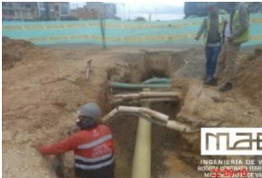
Frente 8.2 Instalación de tubería de 12" pluvial desde PZ No. 894, costado oriental.
