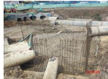
Frente 1.5 Colocación de acero para cámara de red pluvial en canal Calle 38 Sur, costado occidental.
