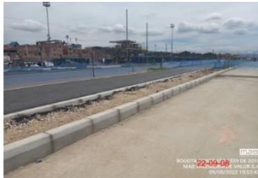
Frente 8.2 Instalación de sardinel A-10 para borde de vía y confinamiento de ciclo ruta, separador.
