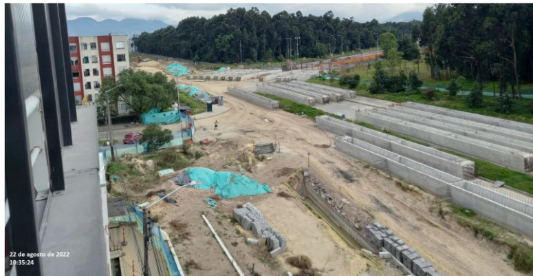
Ilustración 2 Patio de vigas
