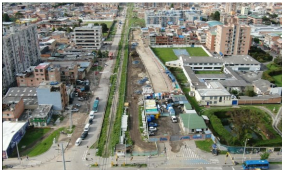
Foto 1 - Instalación colector alcantarillado sanitario Foto 2 - Intervención estructura de vía entre Calle 170 a 172
