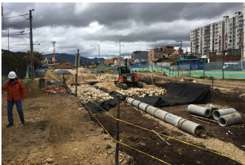
Foto 1 - Instalación colector alcantarillado sanitario Foto 2 - Intervención estructura de vía entre Calle 170 a 172
