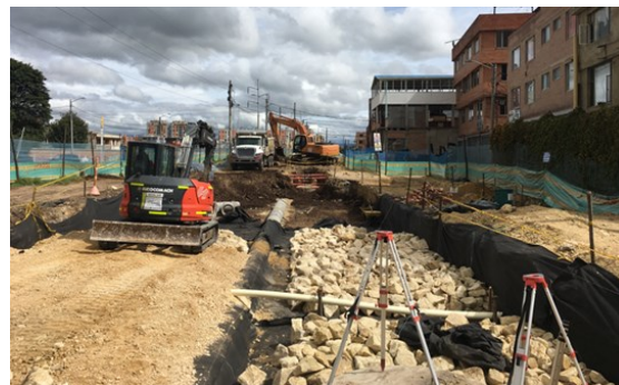
Foto 1 - Instalación colector alcantarillado sanitario Foto 2 - Intervención estructura de vía entre Calle 170 a 172
