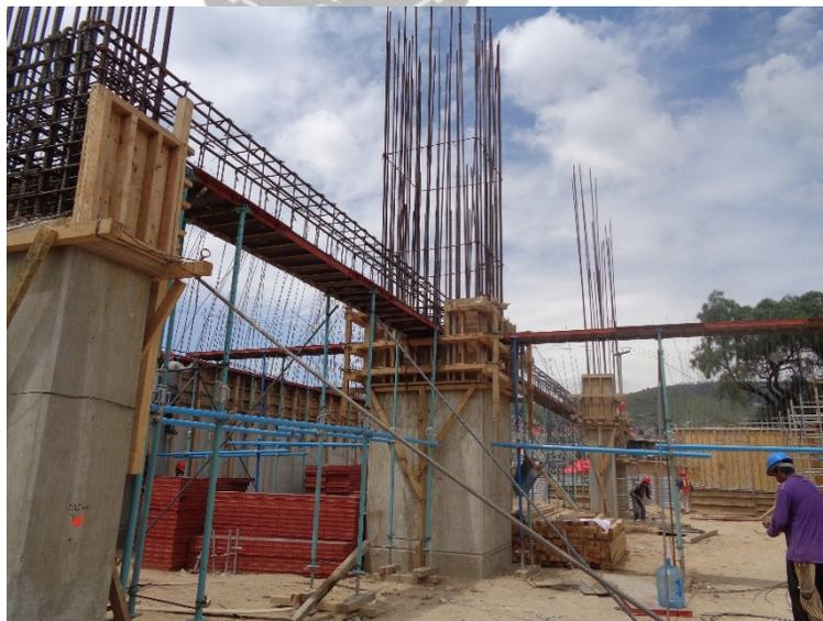
*Figura 13. Obra civil del edificio y pilas de una estación de un telecabina en ámbito urbano.*
