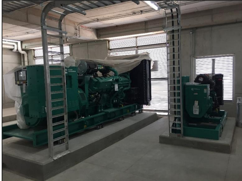
Figura 12. Grupos electrógenos de respaldo en el Mexicable de Ecatepec, México. Fuente: Elaboración propia.
