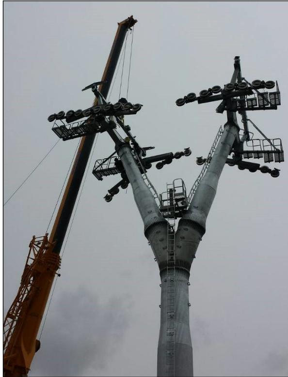
*Figura 10. Montaje de balancines de una torre en “Y”. Mexicable. Ecatepec. México Fuente:
