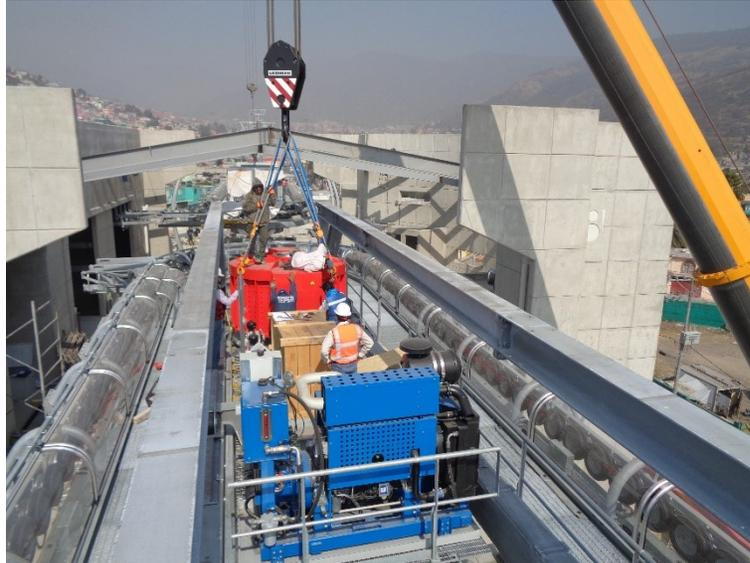
Figura 14. Montaje de un motor directo. Fuente: Elaboración propia
