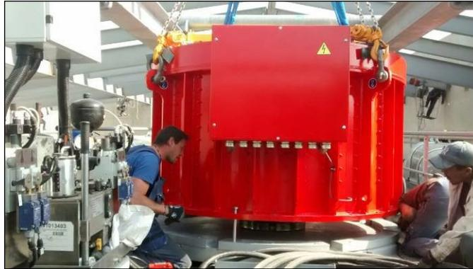
Figura 2. Montaje del motor principal. Mexicable, Ecatepec. Estado de México. Fuente: Elaboración propia.
