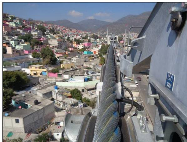
Figura 1. Cable portador/tractor. Fuente: Elaboración propia.
