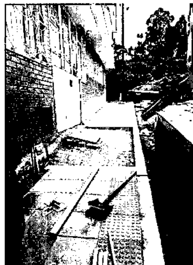
Ilustración 54. Fundida de Rampas en Concreto en el Barrio La Cecilia
