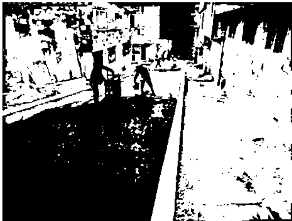
Ilustración 46. Imprimación con Emulsión Asfáltica en el Barrio La Cecilia
