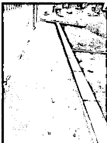
Ilustración 31. Relleno con Subbase Granular Peatonal en el Barrio Altos del Virrey
