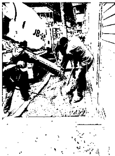
Ilustración 54. Fundida de Rampas en Concreto en el Barrio La Cecilia
