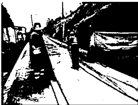
Ilustración 2. Imprimación con Emulsión Asfáltica en el Barrio Guacamayas
