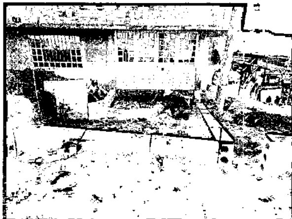
Ilustración 30. Instalación Bordillos A-80 conformación Andenes en el Barrio Altos del Virrey
