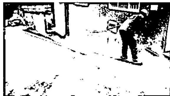
Ilustración 43. Subbase Granular Peatonal para Andenes en el Barrio La Cecilia
